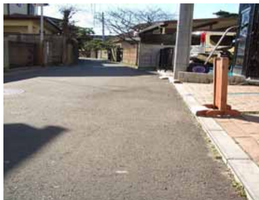
材木座 6 丁目の道路整備
