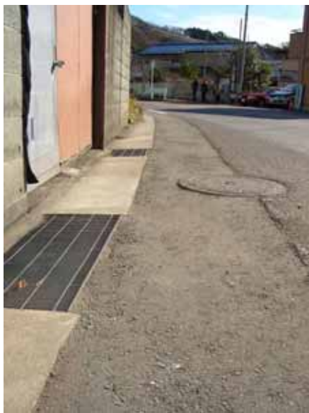
十二所・泉水橋付近の県道整備
